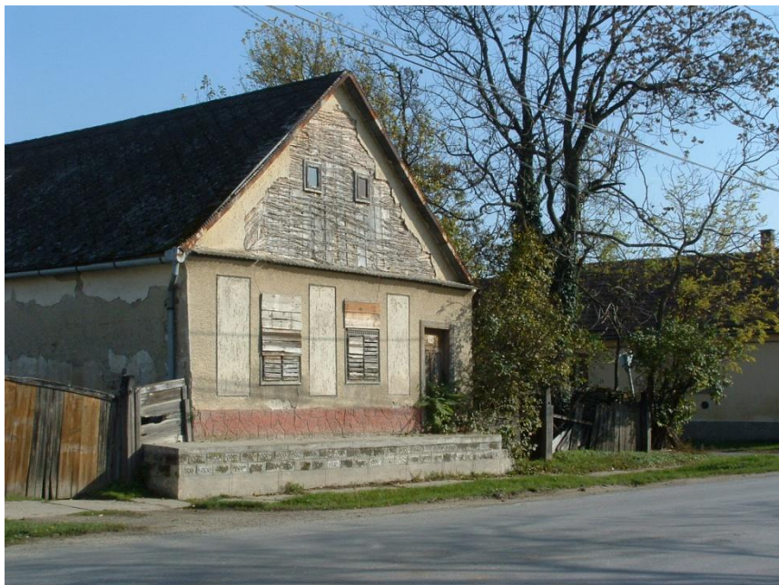
Felújítás előtti állapot
